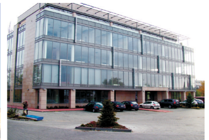
Obiekt: Budynek biurowy w Piasecznie Wykonawca: Łucz-Bud Sp. z o.o.
