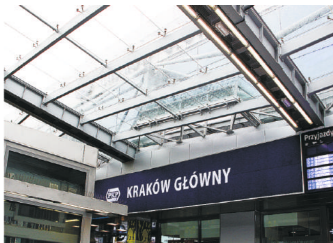
Obiekt: Dworzec Główny w Krakowie Wykonawca: PORR (Polska) S.A.
