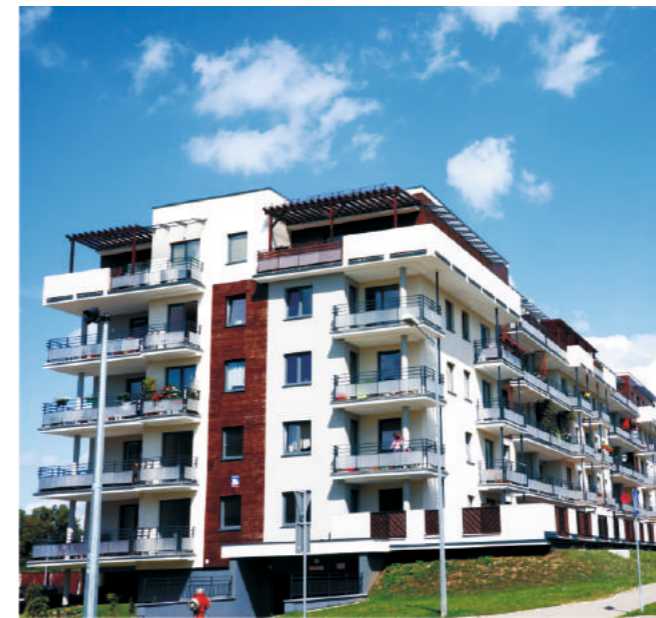
Obiekt: Viva Apartamenty w Elku Inwestor: Dom Elcki Morusiewicz Sp.J.
