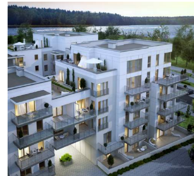
Obiekt: Apartamenty Marina w Elku Inwestor: Rutkowski Development Sp.J.
