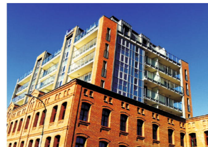
Obiekt: Apartamentowiec przy ul. Krowiej w Warszawie Wykonawca: PBM Południe S.A.
