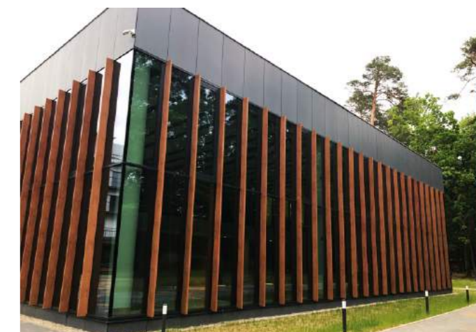
Obiekt: Sanatorium Uzdrowskie Augustów Inwestor: BiaVita Polska S.A.
