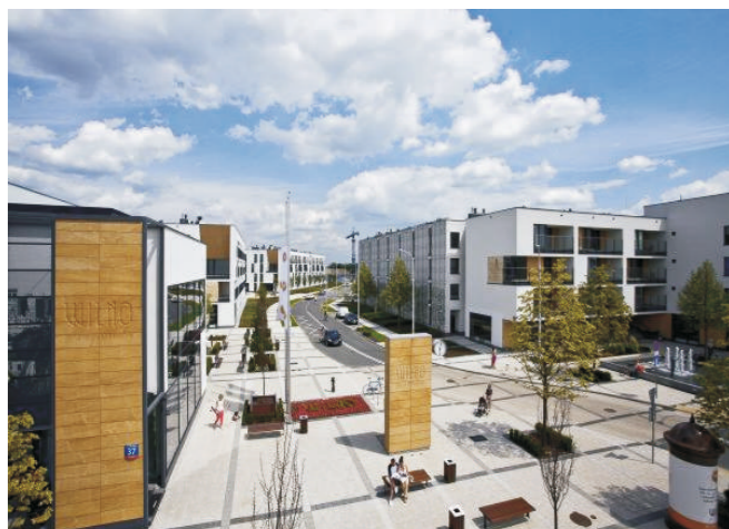
Obiekt: Osiedle Wilno w Warszawie Inwestor: Dom Development S.A.
